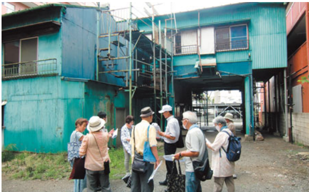
これから工事が始まる移転先を理事が視察
